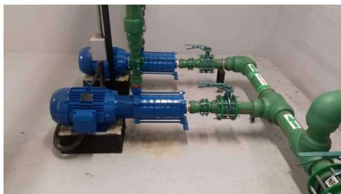
Figura 6 - Elevatória em edificação
