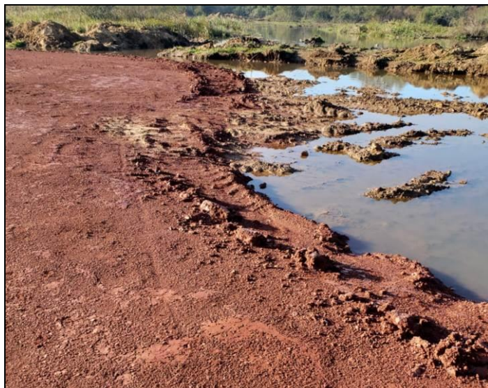
Figura 3: Detalhe da região de contato da água do rio do sinos com o aterro.
