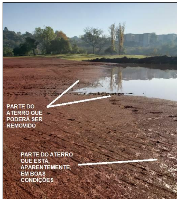
Figura 5: Imagem mostrando que volume principal do aterro encontra-se em boas condições.
