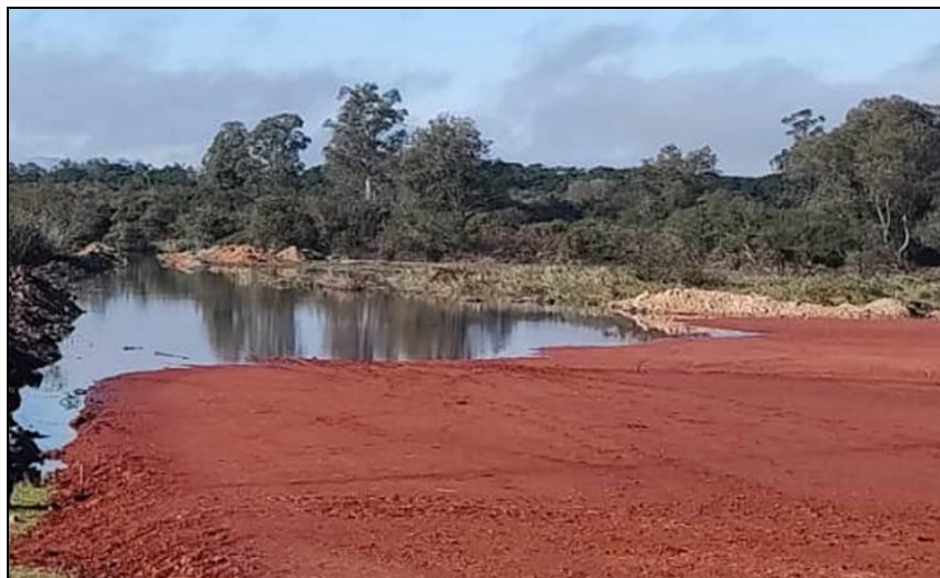
Figura 1: Imagem do local da obra, indicando o avanço nível do Rio do Sinos, devido às chuvas ocorridas no mês de Maio .Foto registrada em 23/5/2022.
