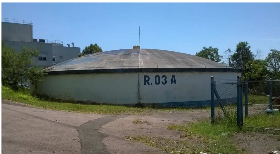
Figura 1: Reservatório Maurício Cardoso.
