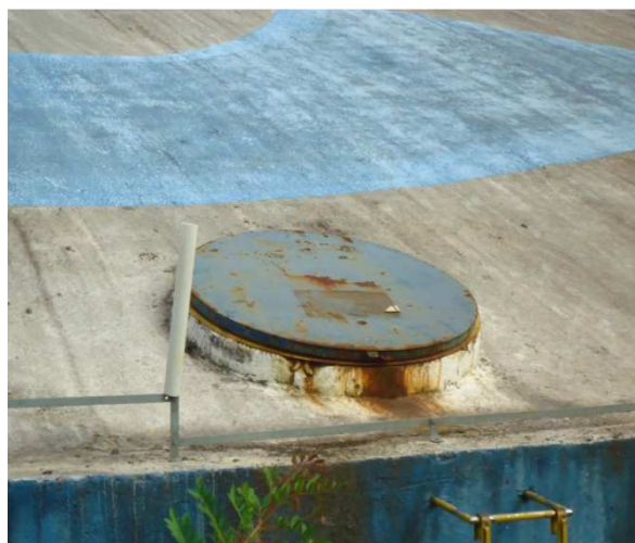
Figura 8: Instalação de nova tampa de acesso substituindo a existente que já possui pontos de corrosão e também proteção.
