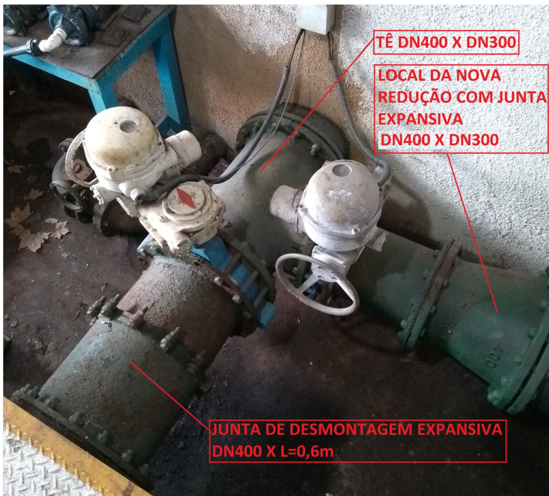
Foto 1: Fotografia superior de um Tê e junta de desmontagem que serão trocados.
