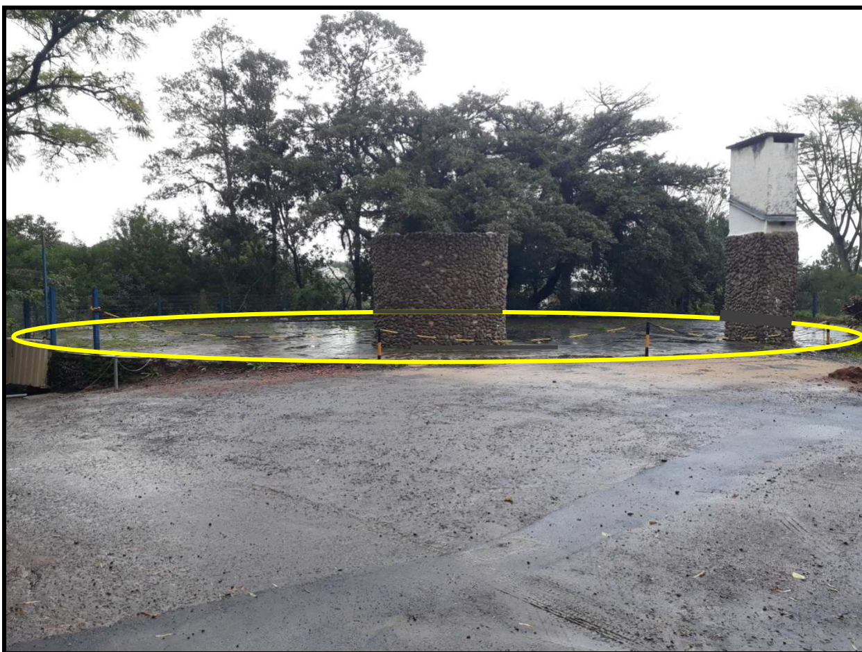
Foto 11 | Laje do antigo Restaurante , onde serão executados os serviços acima previstos
