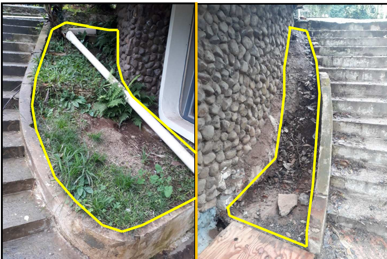
Foto 6 | Áreas confinadas entre as escadas dos dois lados do antigo Restaurante e as paredes laterais do mesmo
