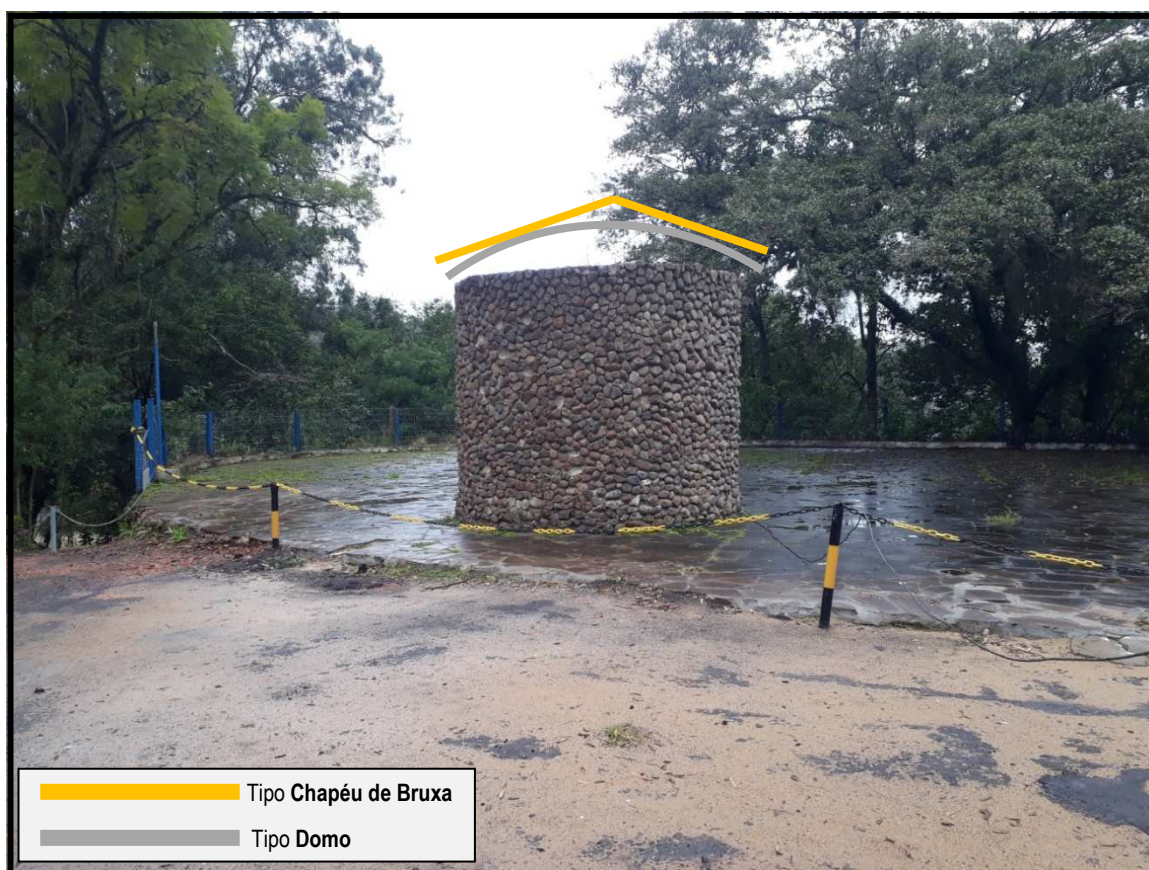
Foto 7 | Tipos de coberturas propostos ao poço de ventilação do antigo Restaurante
