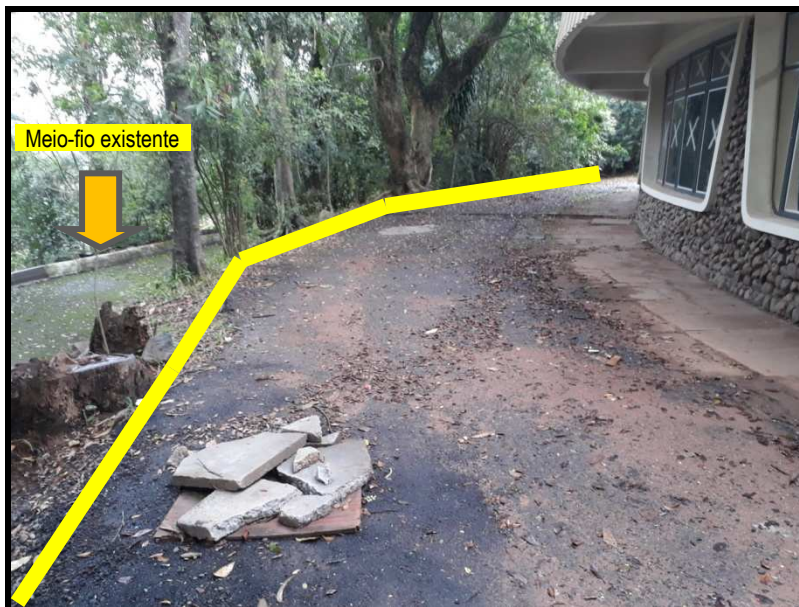
Foto 8 | Linha de meio-fio a ser implantada na área frontal do antigo Restaurante
