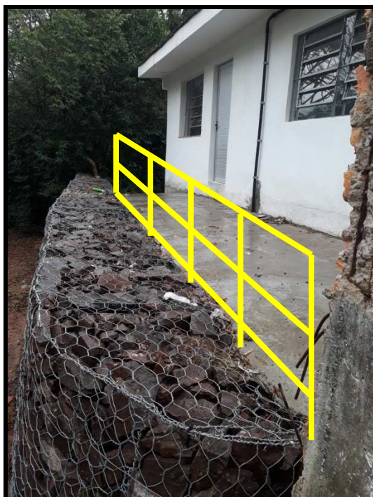
Foto 4 | Parapeito projetado entre o passeio da Casa de Administração e o muro de gabião (à esquerda)
