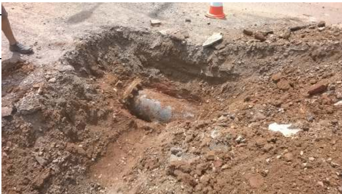
Figura 2 – Foto da sondagem da tubulação na margem da Avenida Alcântara
