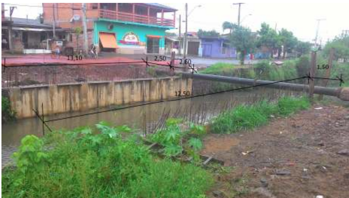
Figura 1 – Foto da ponte tirada da margem da Av. 14 Bis
