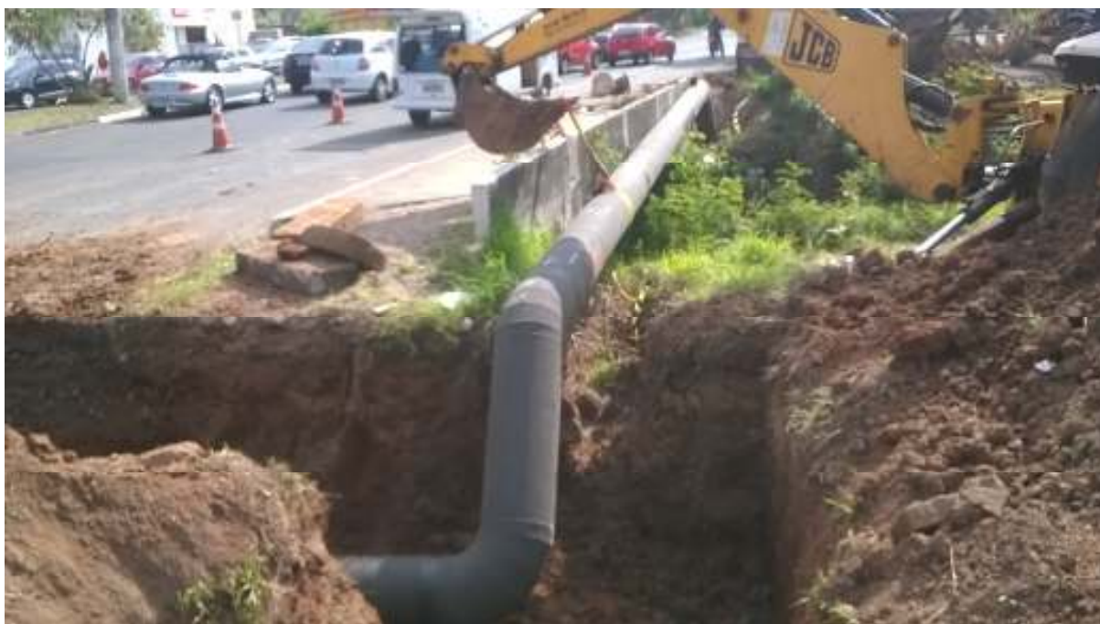
Figura 14 –Execução da travessia na Vitor Hugo Kunz do cavalete em aço
